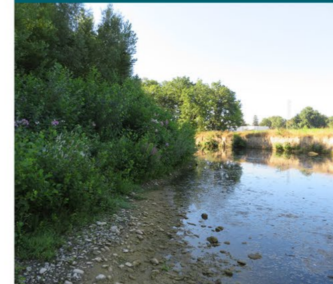
DIG-W / avant travaux / dévégétalisation + scarif
