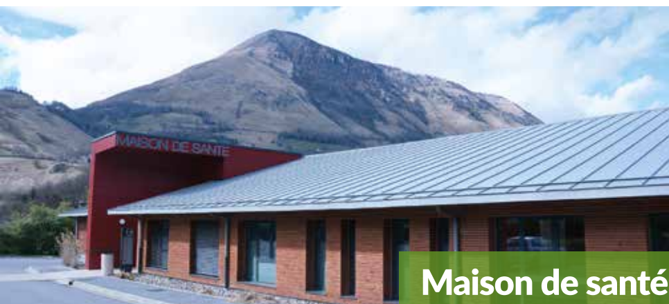
Maison de santé de la vallée d'Aspe à Bedous, ouverte en 2015.
