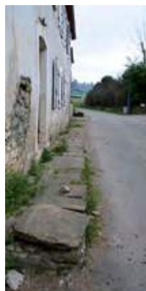
Dalles de pierres marquant le seuil. Estialescq.
