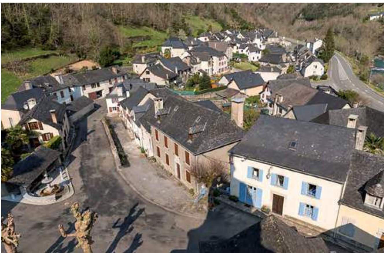
Vue des îlots bâtis. Sarrance.
