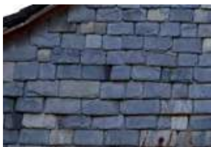
Ardoises posées au clou pour le bardage d'un pignon de grange. Sainte-Colome.
