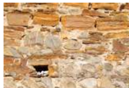
Appareil de grès, galets et moellons calcaires. Buziet.
