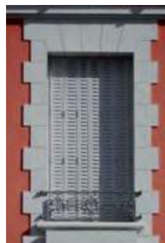
Volets repliables métalliques à persiennes.
