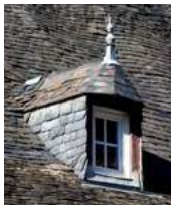
Lucarne à croupe avec épi de toit en zinc, joues en ardoise. Gère-Bélesten.
