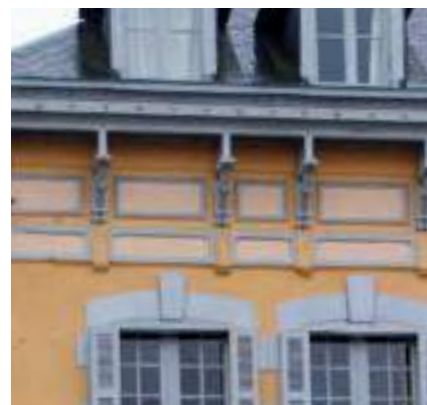
Débord de toit sur consoles sculptées. Oloron Sainte-Marie.
