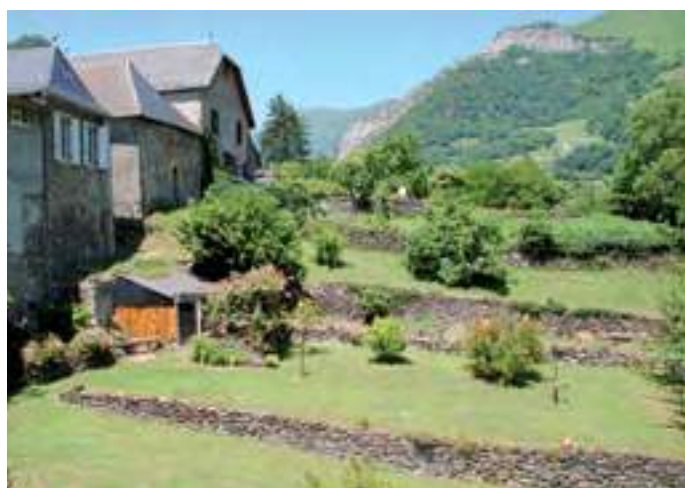
Murs de soutènements entre parcelles
