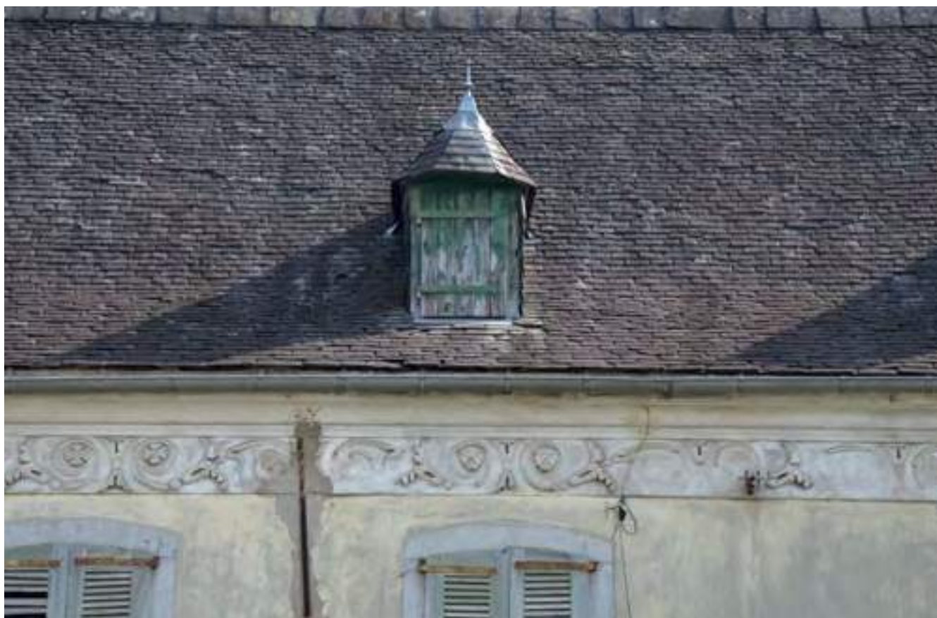
Corniche moulurée en plâtre et plate bande avec décor de rinceaux, croix patées et masques en stuc. Aramits.
