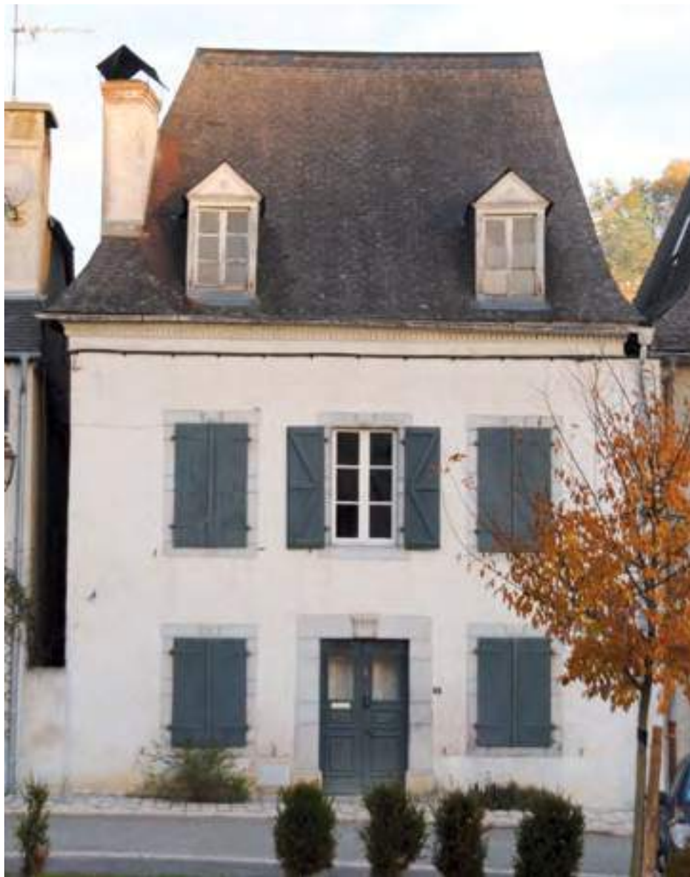
Maison bourgeoise dans le contexte urbain de la bastide de Rébénacq. Façade d'ordonnance classique et symétrie axée des travées d'ouvertures. Fin XVIII e siècle.
