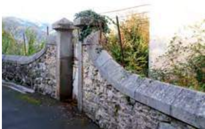
Muret à Sévignacq-Meyrac.
