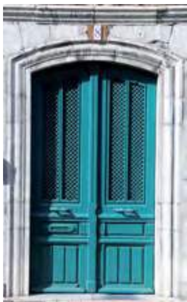
Porte avec sa ferronnerie. Oloron Sainte-Marie.
