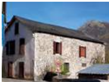
Toiture simple à deux pentes. Bielle.
