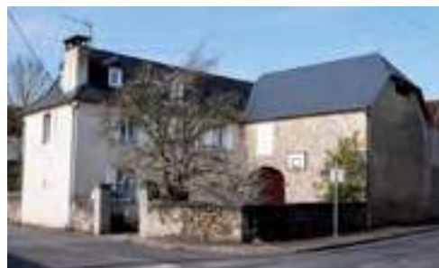
Maison et grange formant une cour. Verdets.
