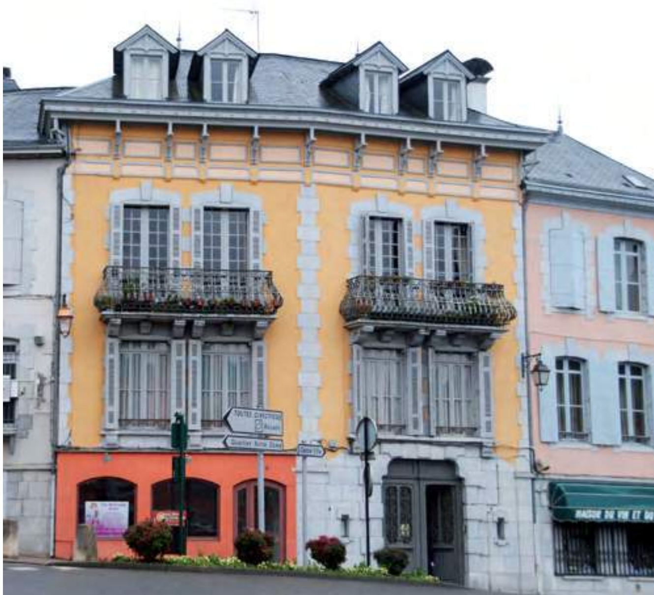
Architecture éclectique de la période industrielle, immeuble de rapport. Fin XIX e siècle. Oloron Sainte-Marie, place Mendiouldou.
