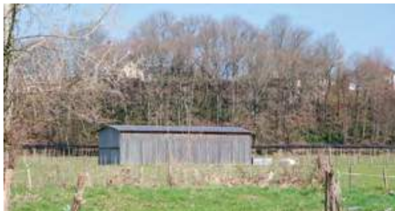
Bâtiment contemporain répondant à une volumétrie simple, en appui contre un coteau boisé. Bardage bois vertical. Commune de Moumour.
