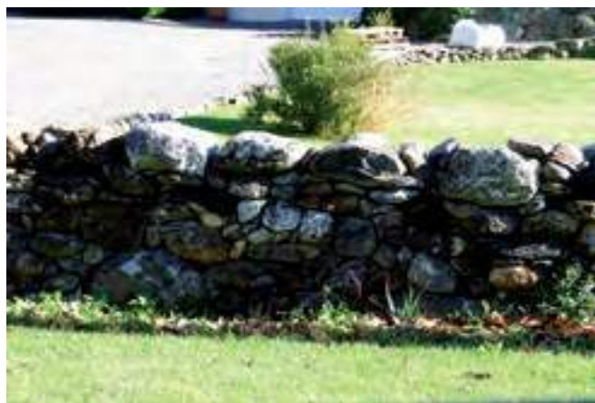
Muret séparatif appareillé en pierres sèches entre Aste-Béon et Louvie Soubiron.
