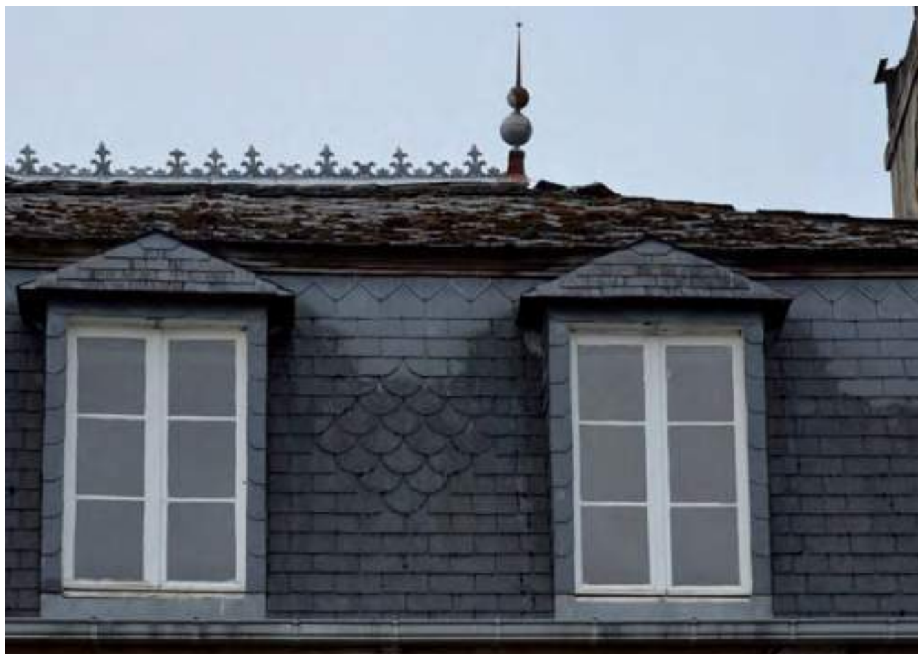
Lucarnes en bâtière sur le brisis d'un toit à la Mansart. Décor d'ardoises taillées en écailles de poissons dans un losange entre les deux lucarnes et épi de faîtage et faîtière en zinc découpé. Lasseube.
