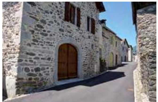
Les épaissements et les resserrement de la rue forment un paysage varié. Village de Borce Source : Pays d'art et d'histoire © Clément HERBAUX.
