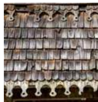
Bardeaux de bois. Saint-Christau. Source : VPAH © C. HERBAUX.
