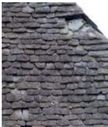
Ardoises épaisses posées au clou. Oloron Sainte-Marie.
