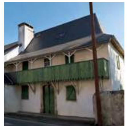
Le pan du coyau est prolongé pour servir de couverture à la galerie ouverte. Féas. Source : VPAH © C. HERBAUX.
