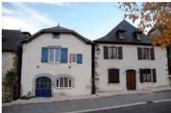
Maisons avec pignon sur rue à Rébénacq.
