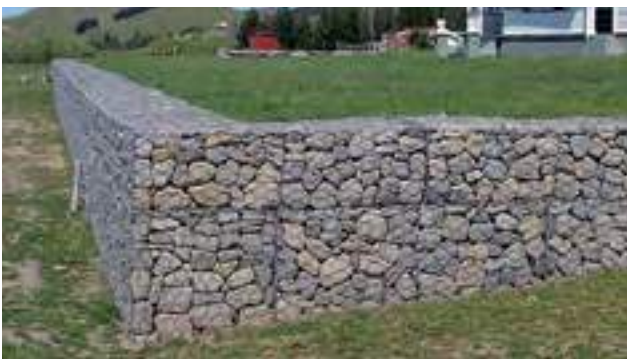
Exemple de murs gabions en soutènement.
