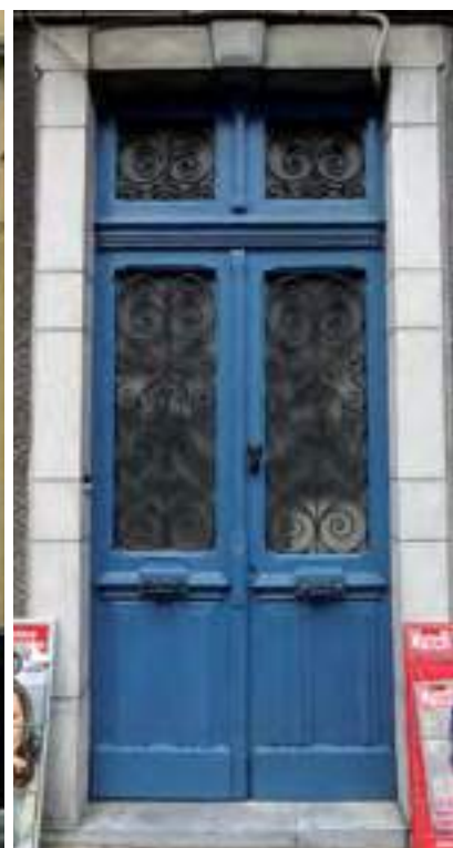
Porte d'entrée vitrée avec imposte*, dotée d'une grille. XIX e siècle.
