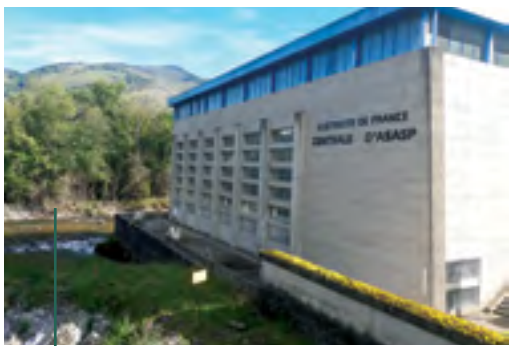
Centrale hydroélectrique d'Asasp-Arros
