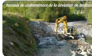
Le confortement du talus de remblai de la déviation de Bedous a été un chantier marquant de l'année 2014. Suite aux crues successives du gave d'Aspe, le lit du gave s'est déplacé d'environ 40 m vers la chaussée, poursuivant ainsi l'érosion de la berge en rive droite au point de menacer l'intégrité de la RN134.
